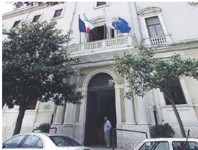
INFRAZIONE AL CDS Il palazzo che ospita la Provincia
