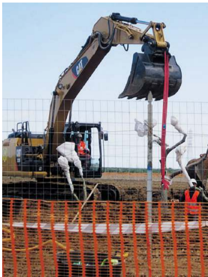
IL CANTIERE La condotta attraversa anche il territorio di Lecce
